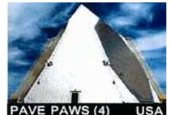
« active » Phased Array antenna using MMIC
